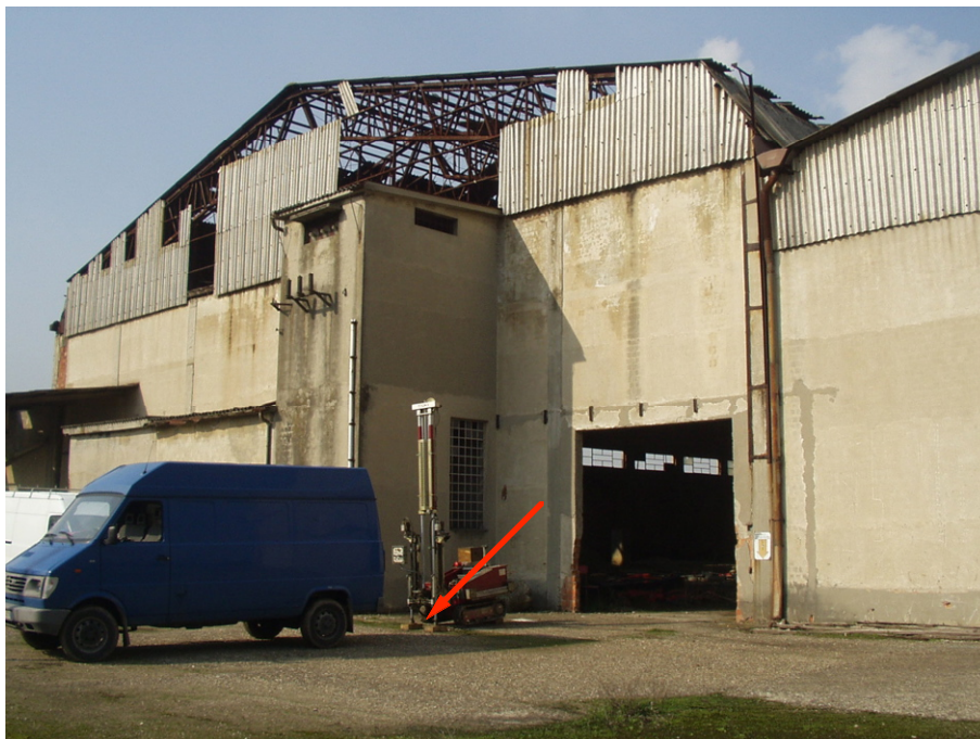
FOTO 2 - La fotografia raffigura il lato sud-occidentale del capannone esistente (che verrà demolito), mentre la freccia indica l'ubicazione della prova n. 2.
