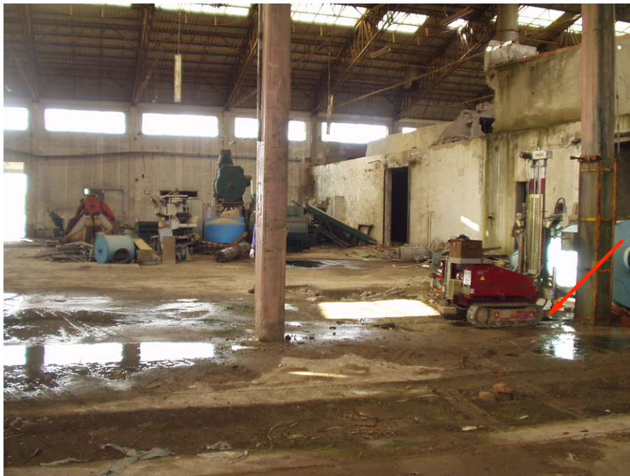
FOTO 1 - L'immagine mostra l'interno del capannone esistente (che verrà demolito) e la freccia individua l'ubicazione della prova n. 1.
