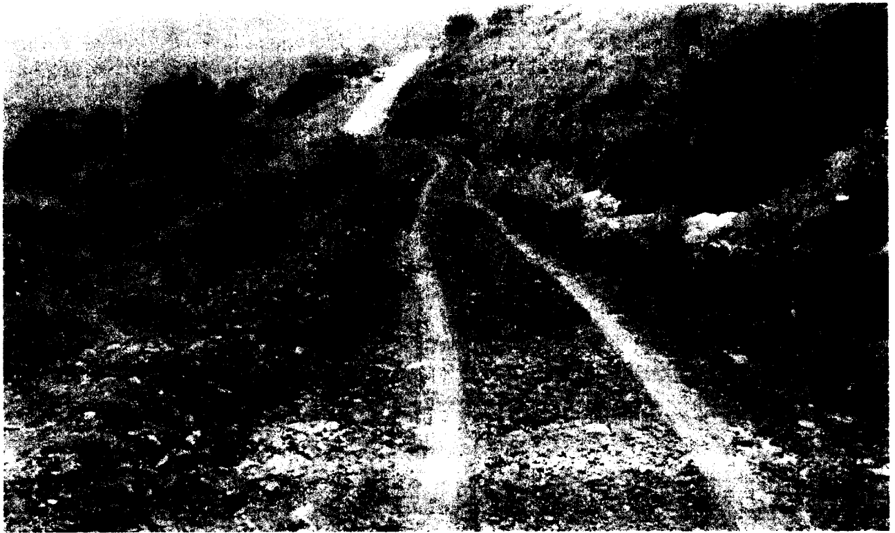
FOTO N. 4 (RIPRISTINO STRADA C.DA S. CROCE)
