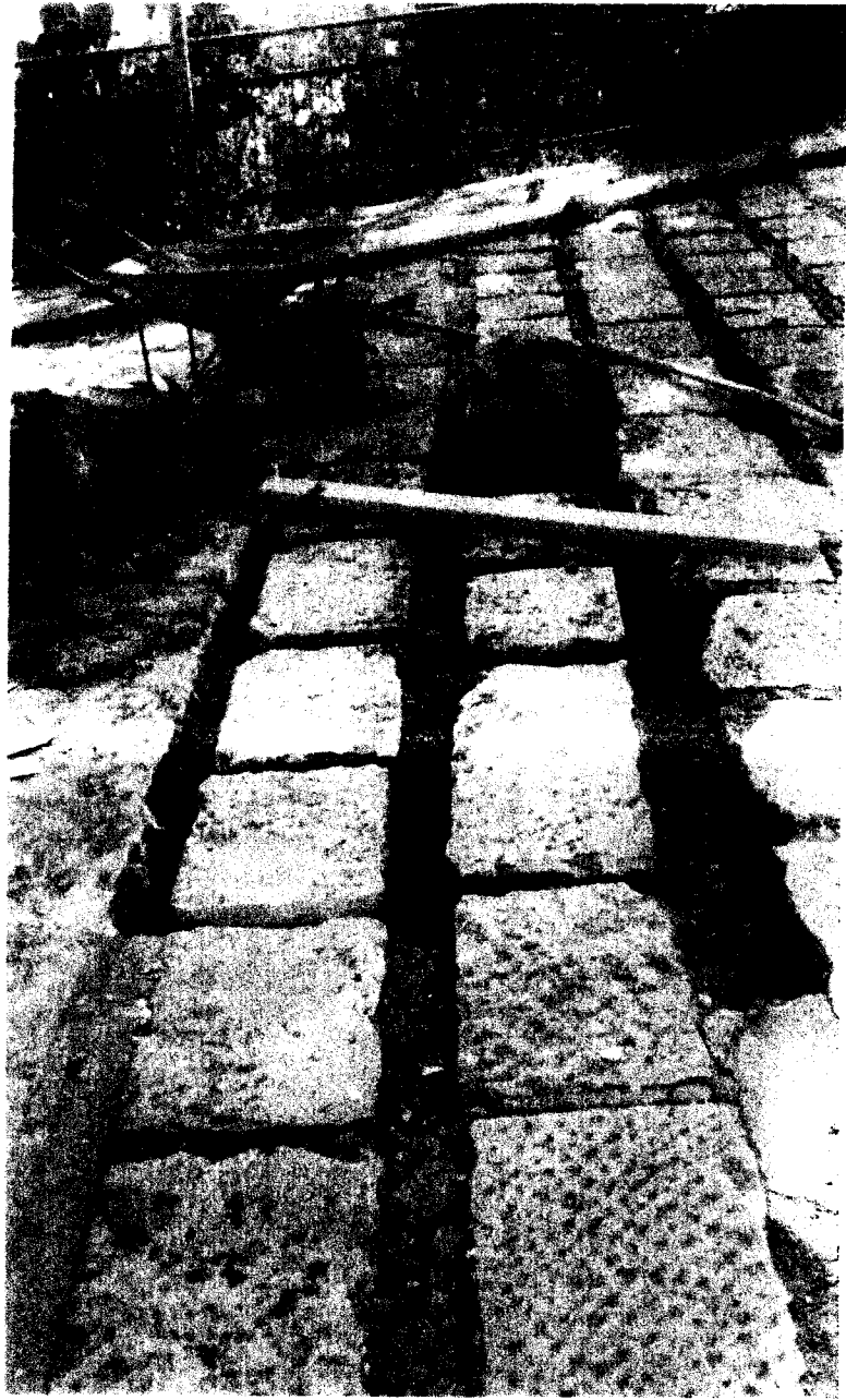
FOTO N. 9 (RIPRISTINO PAVIMENTAZIONE VIA LONGO)
