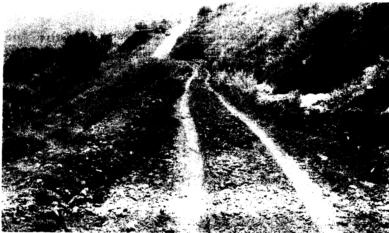
FOTO N. 4 (RIPRISTINO STRADA C.DA S. CROCE)
