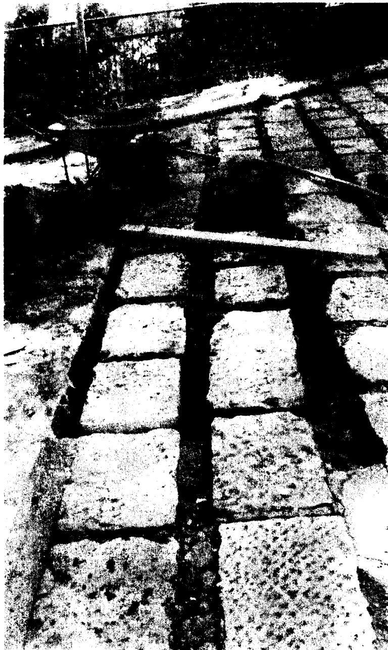
FOTO N. 9 (RIPRISTINO PAVIMENTAZIONE VIA LONGO)
