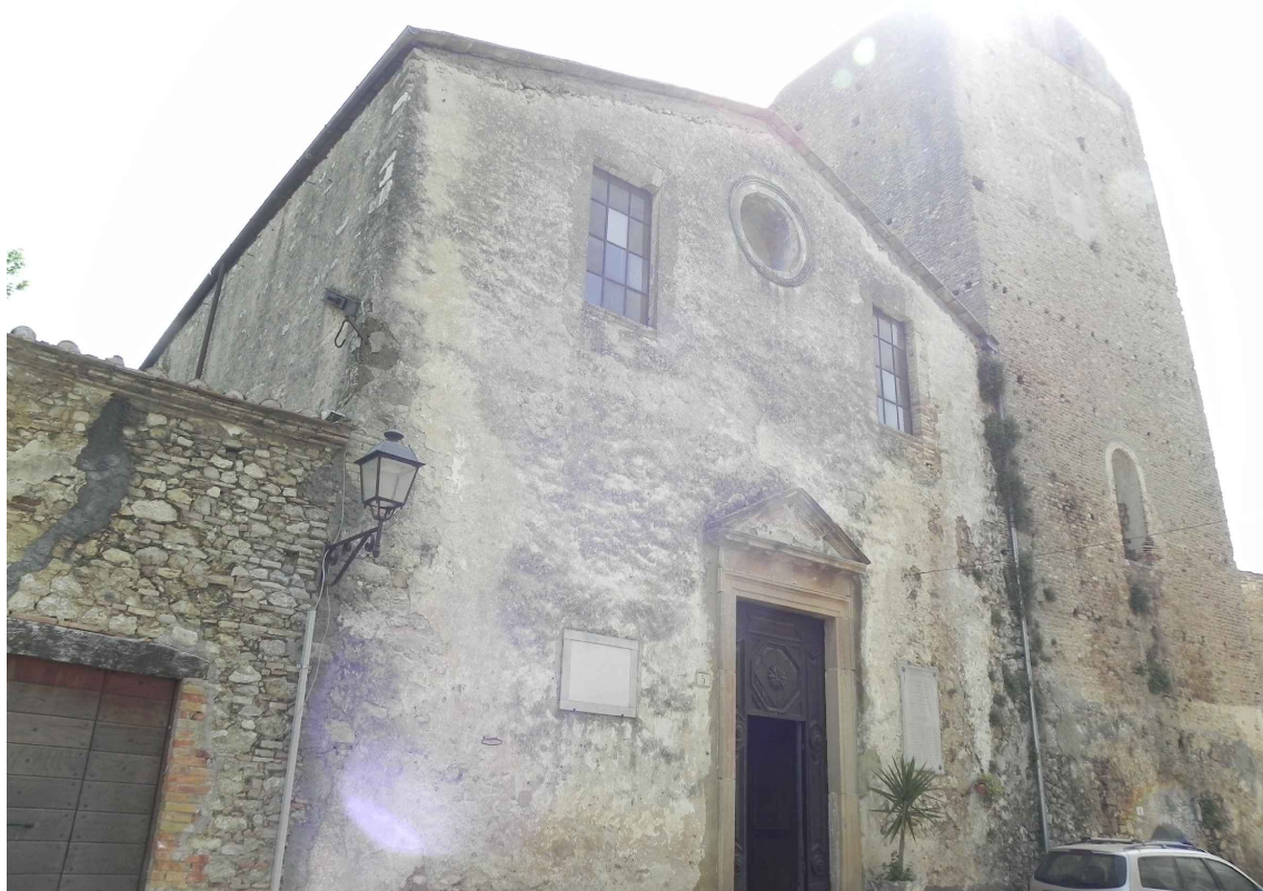
FOTO 1 (vista lato Ovest)
