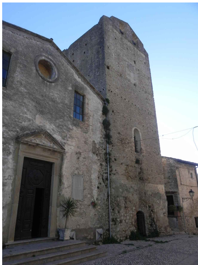
FOTO 4 (vista lato Ovest)
