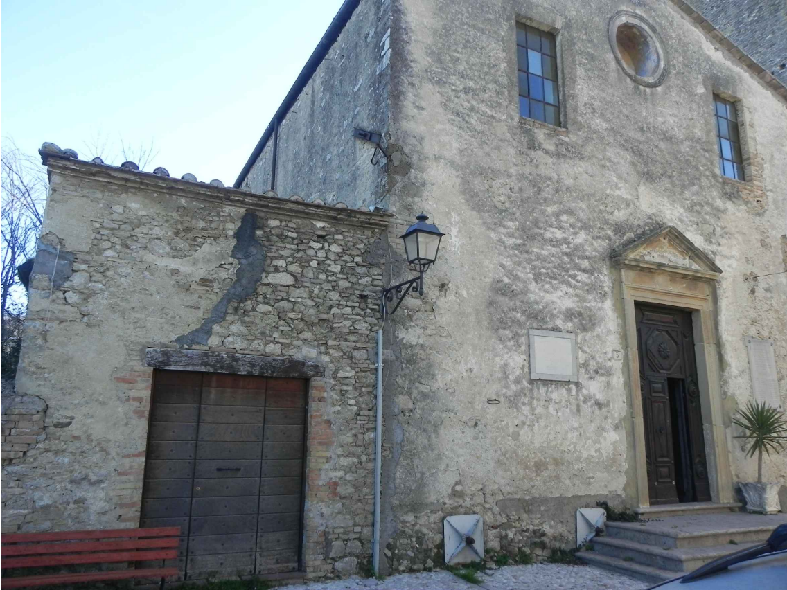
FOTO 5 (vista lato Ovest)
