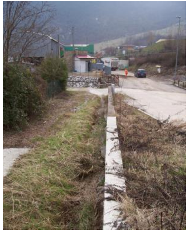
Foto 2 Particolare dell'alveo a valle dell'attraversamento
