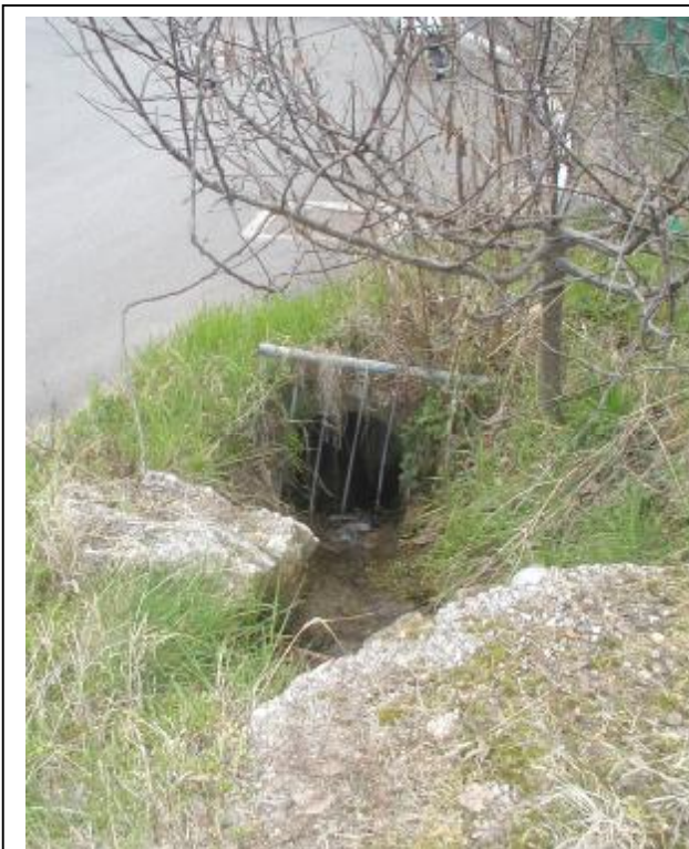
Foto 8 Sezione di monte dell'attraversamento
