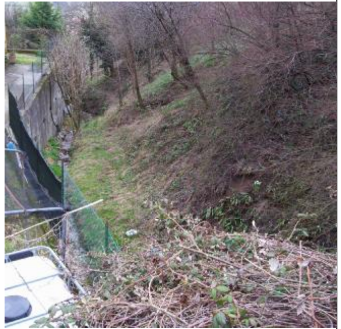
Foto 2 Alveo a valle dell'attraversamento A.
