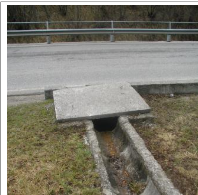
Foto 10 Sezione di monte dell'attraversamento
