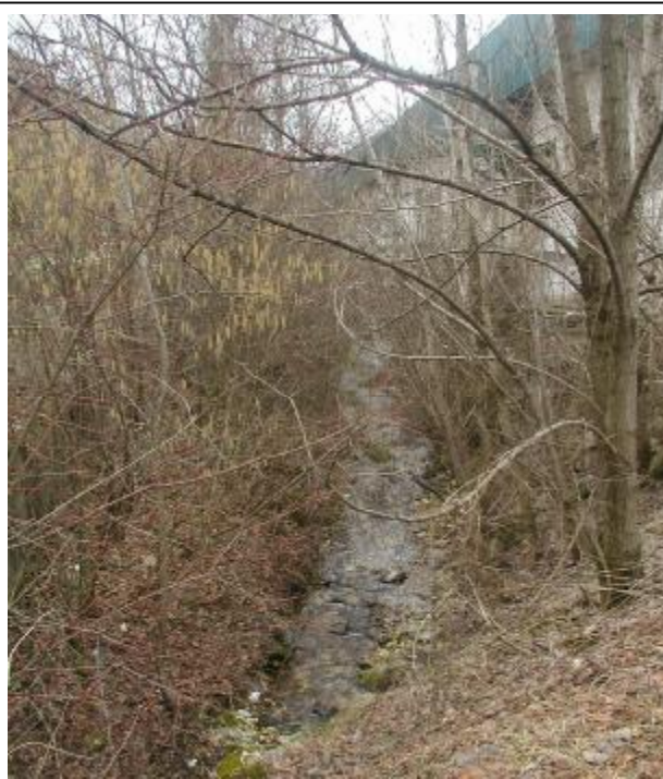
Foto 3 Tratto d'alveo a monte dell'attraversamento B
