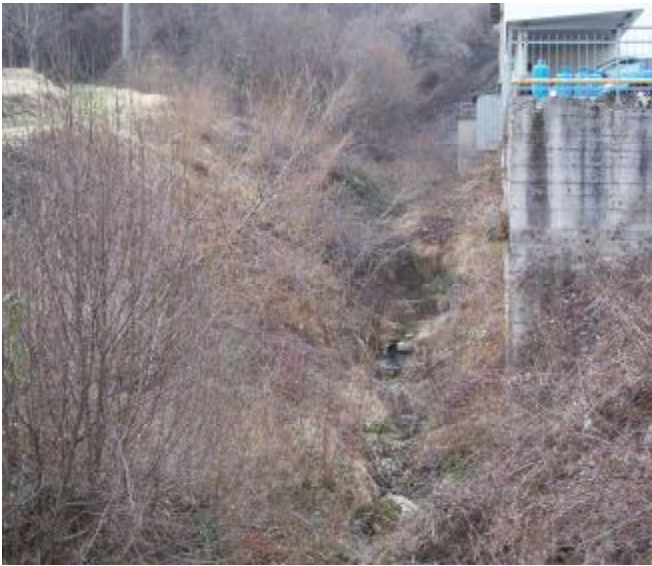
Foto 1 Particolare dell'alveo a monte dell'attraversamento
