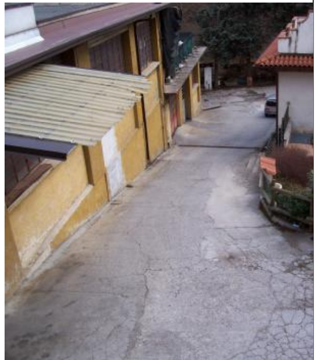
Foto 4 Tratto tombinato a valle della sezione di monte dell'attraversamento F
