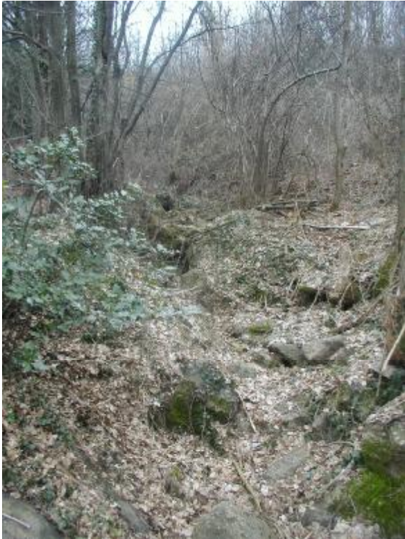
Foto 1 Particolare dell'alveo a monte dell'attraversamento
