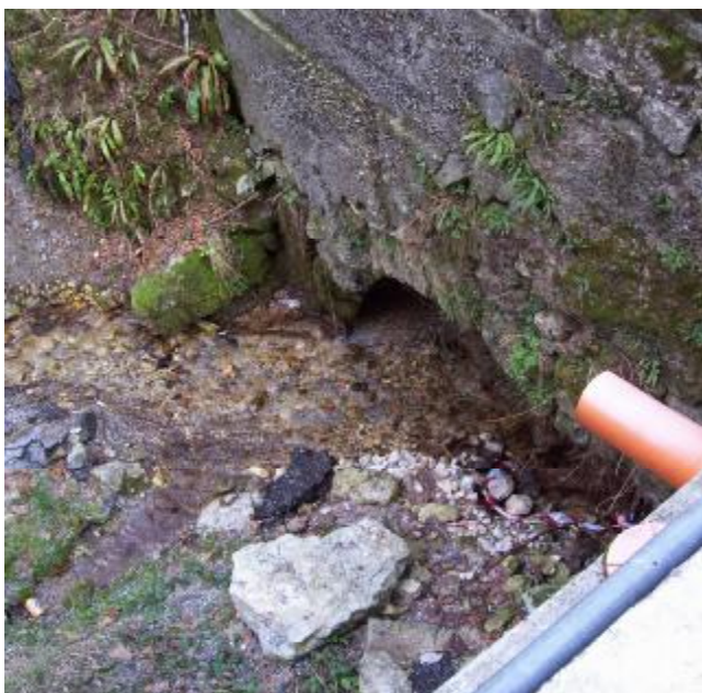
Foto 9 Sezione di monte dell'attraversamento
