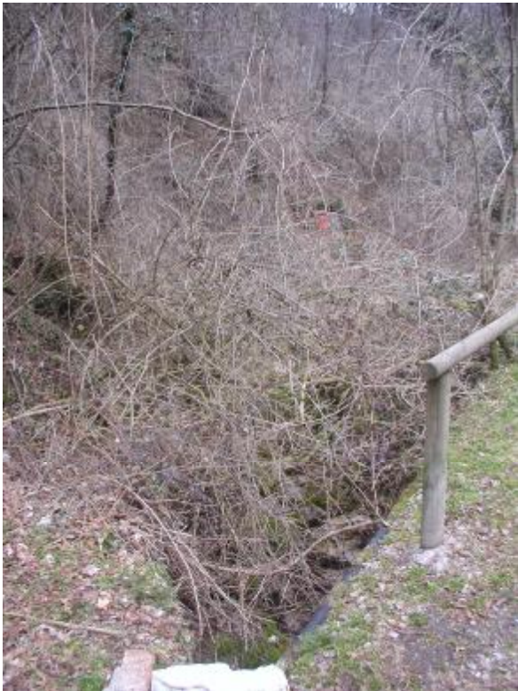
Foto 1 Particolare dell'alveo a monte dell'attraversamento A
