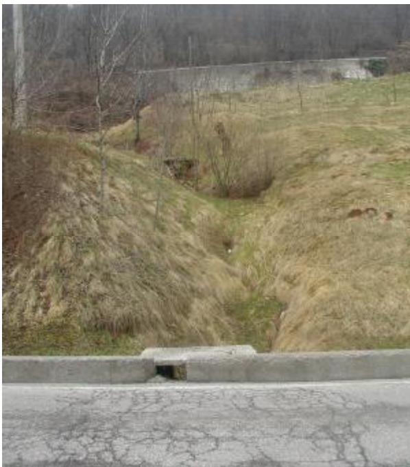
Foto 3 Tratto d'alveo a monte dell'attraversamento C
