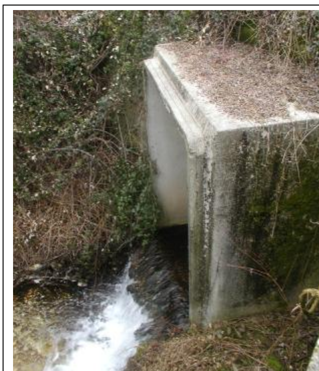
Foto 8 Vista dell'attraversamento da valle
