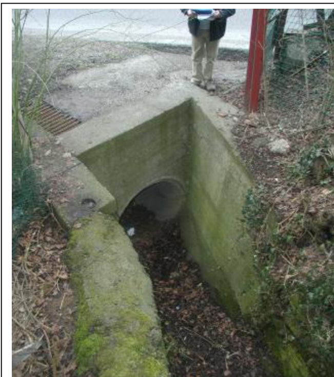
Foto 2 Sezione di monte dell'attraversamento
