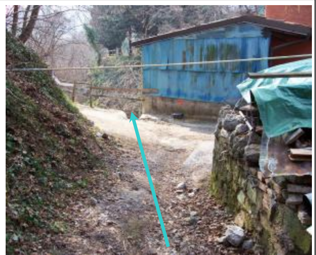
Foto 2 Particolare del guado
