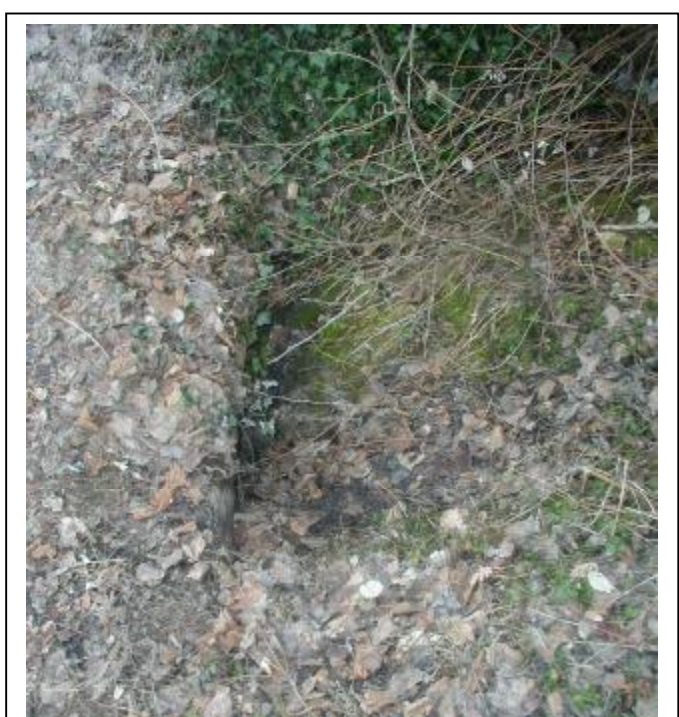
Foto 2 Sezione di monte dell'attraversamento
