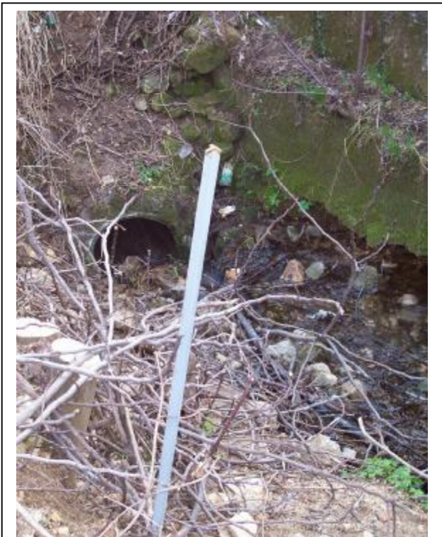
Foto 13 Sezione di monte dell'attraversamento
