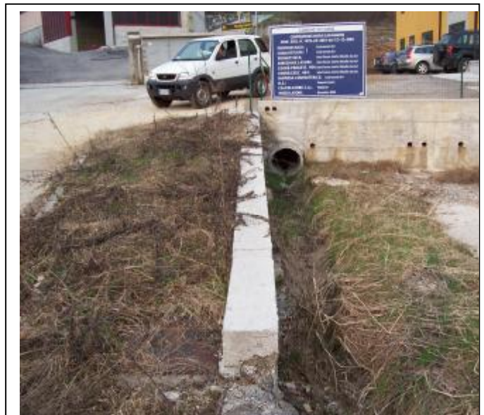
Foto 4 Sezione di valle dell'attraversamento
