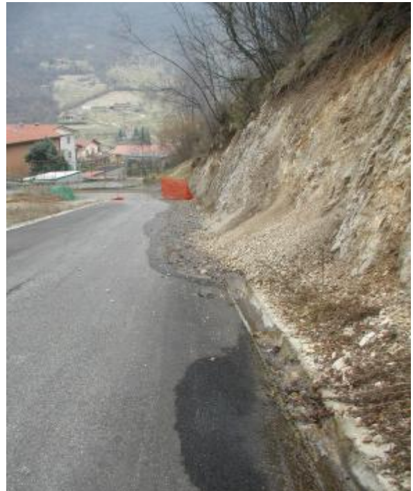
Foto 2 Particolare della canaletta in cls a monte dell'attraversamento A
