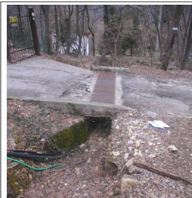
Foto 4 Sezione di monte dell'attraversamento
