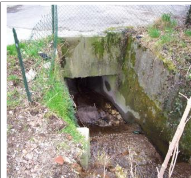
Foto 4 Sezione di monte dell'attraversamento
