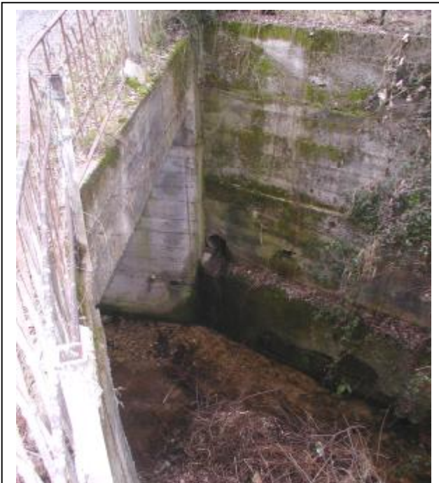
Foto 7 Sezione di monte dell'attraversamento
