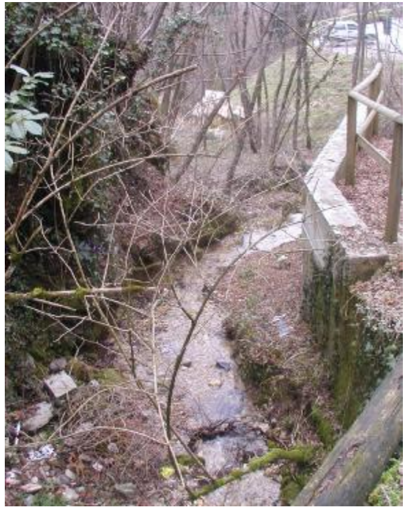
Foto 2 Alvo con sponde vegetate a valle dell'attraversamento A
