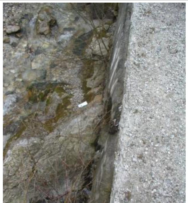
Foto 4 Sezione di valle dell'attraversamento, punto di confluenza nel Torrente Garza
