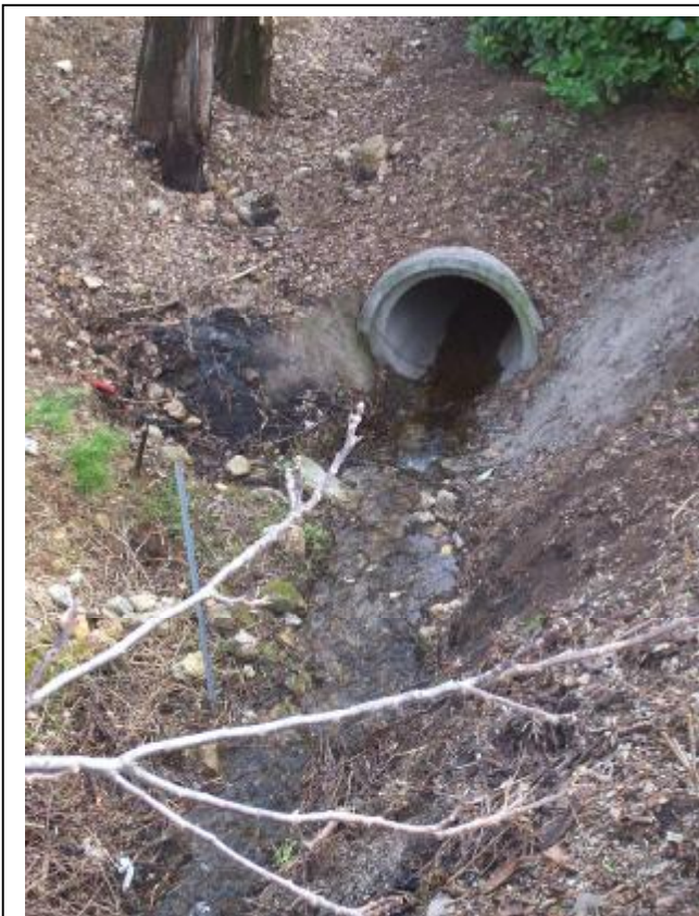
Foto 11 Sezione di monte dell'attraversamento
