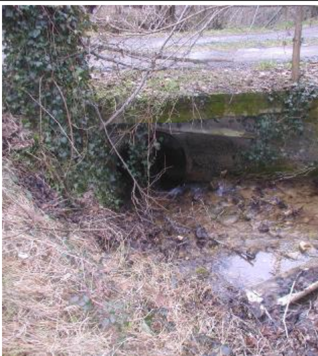
Foto 4 Sezione di monte dell'attraversamento
