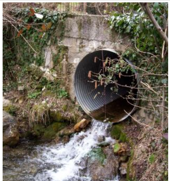
Foto 6 Sezione di valle dell'attraversamento
