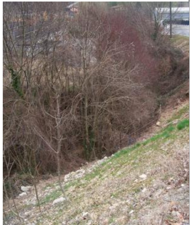
Foto 4 Alveo fittamente vegetato a monte dell'attraversamento B
