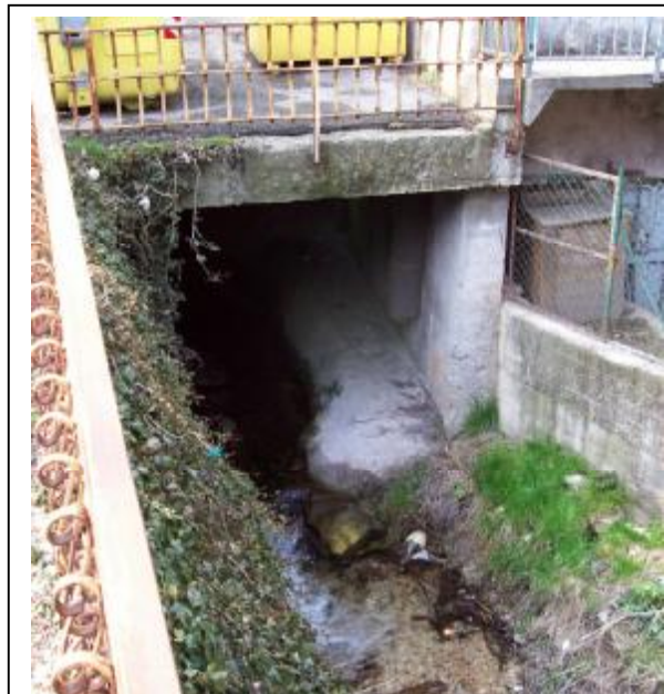
Foto 10 Sezione di valle dell'attraversamento
