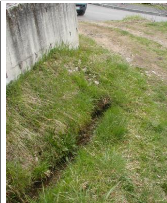
Foto 6 Sezione di monte dell'attraversamento
