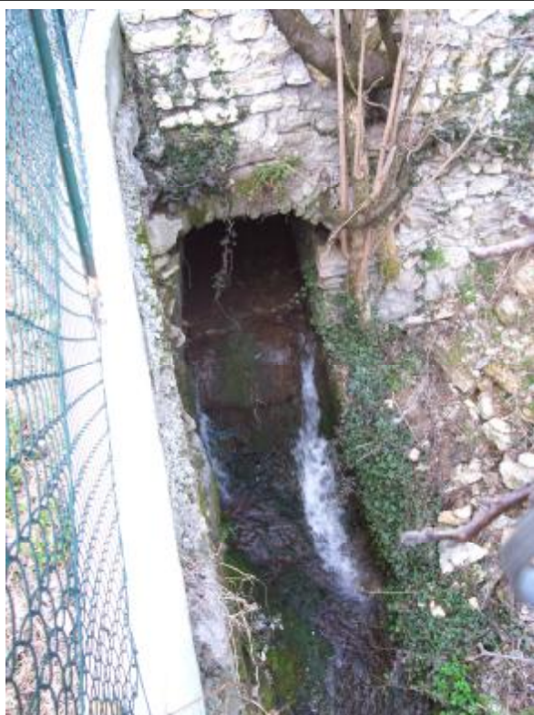
Foto 9 Sezione di valle dell'attraversamento
