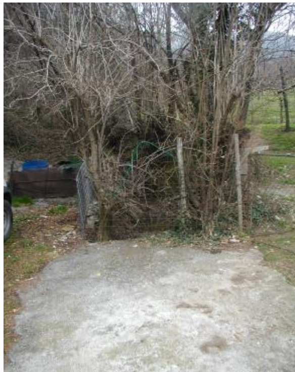
Foto 2 Alveo vegetato a monte dell'attraversamento A
