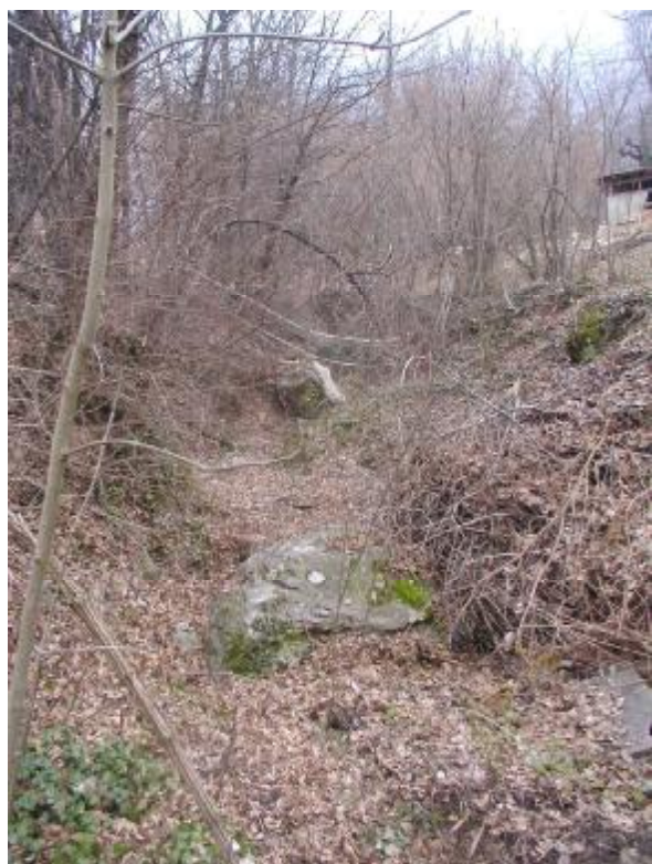
Foto 1 Particolare dell'alveo a monte del guado
