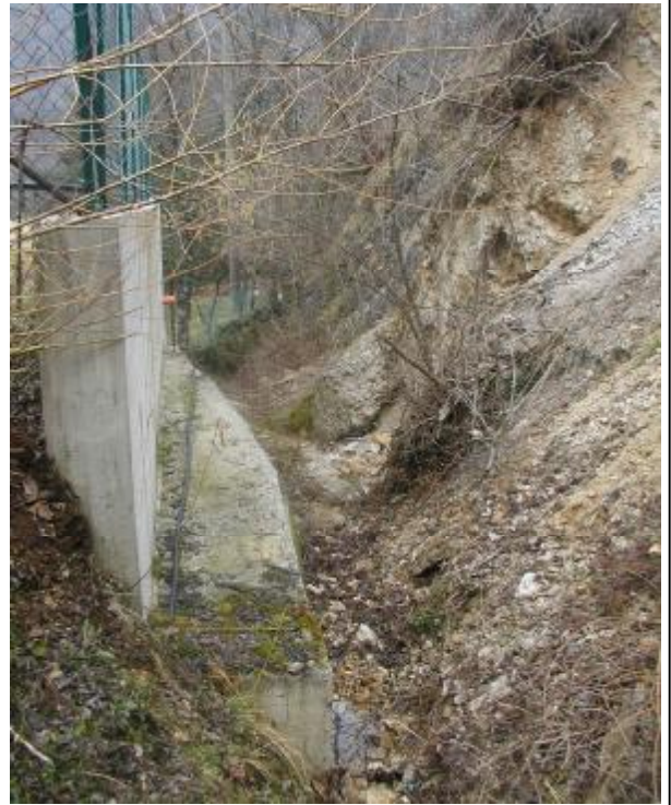
Foto 2 Alveo parzialmente impostato in roccia a quota 460 m s.l.m.
