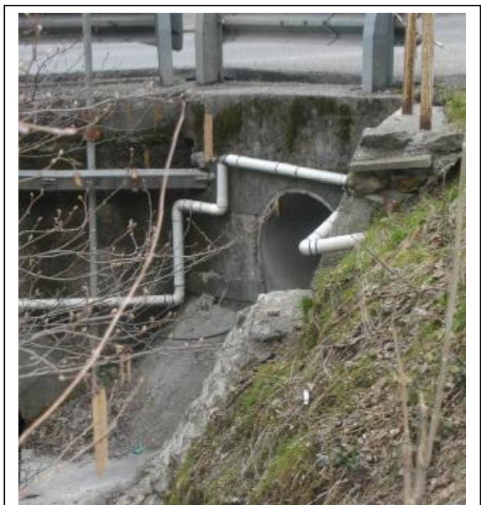
Foto 3 Sezione di valle dell'attraversamento, punto di confluenza nel Torrente Garza
