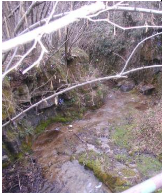
Foto 2 Particolare dell'alveo in roccia a valle dell'attraversamento
