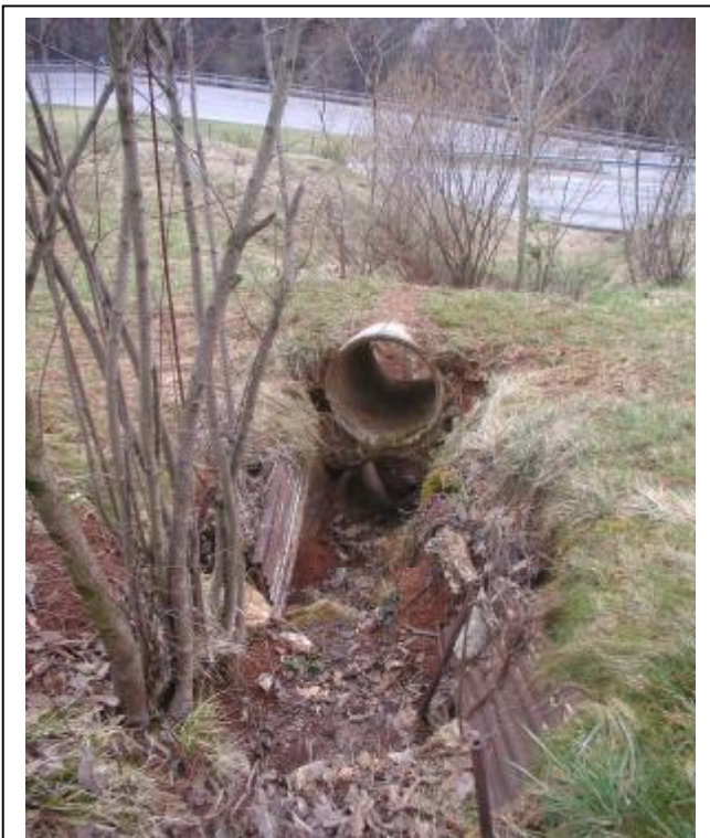
Foto 7 Sezione di monte dell'attraversamento
