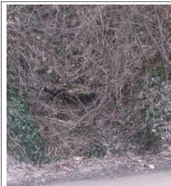
Foto 1 Particolare dell'alveo immediatamente a monte dell'attraversamento.
