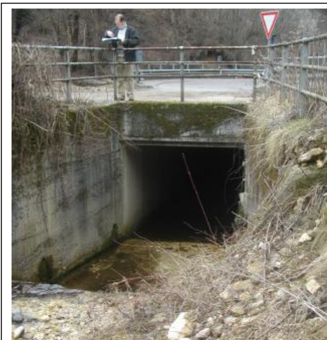
Foto 5 Sezione di monte dell'attraversamento
