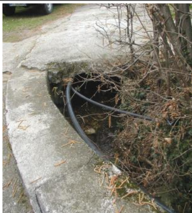
Foto 5 Sezione di valle dell'attraversamento
