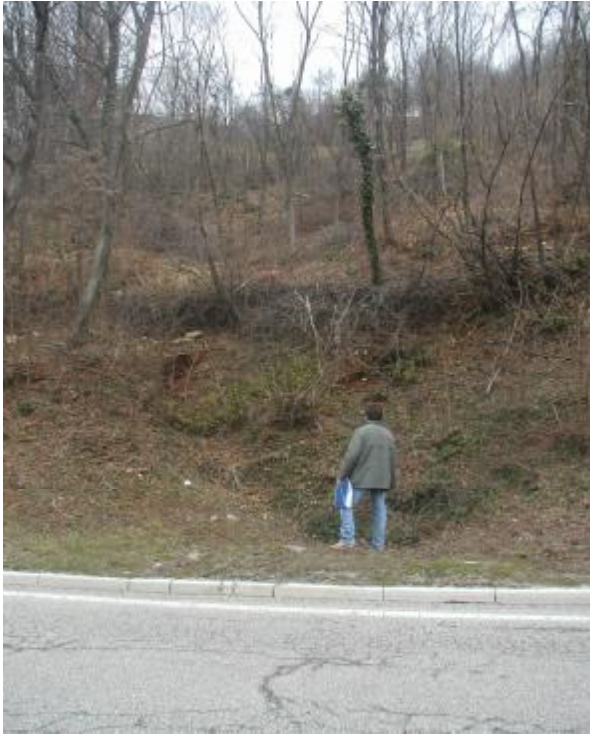
Foto 1 Alveo a monte dell'attraversamento A
