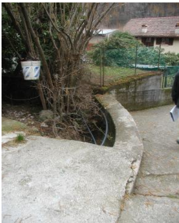
Foto 3 Tratto regimato a valle dell'attraversamento A
