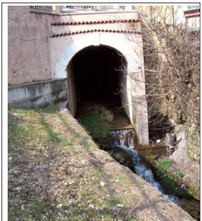
Foto 12 Sezione di valle dell'attraversamento
