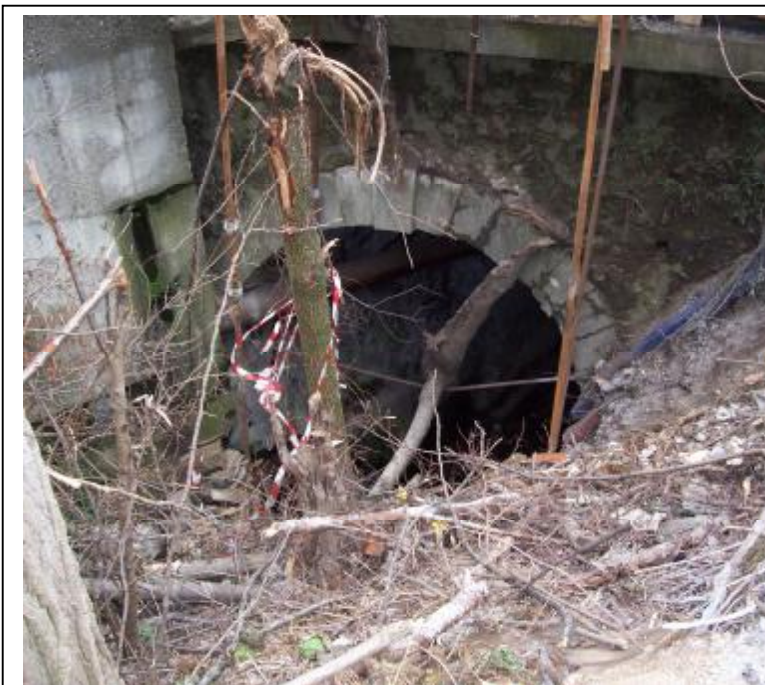
Foto 5 Sezione di monte dell'attraversamento
