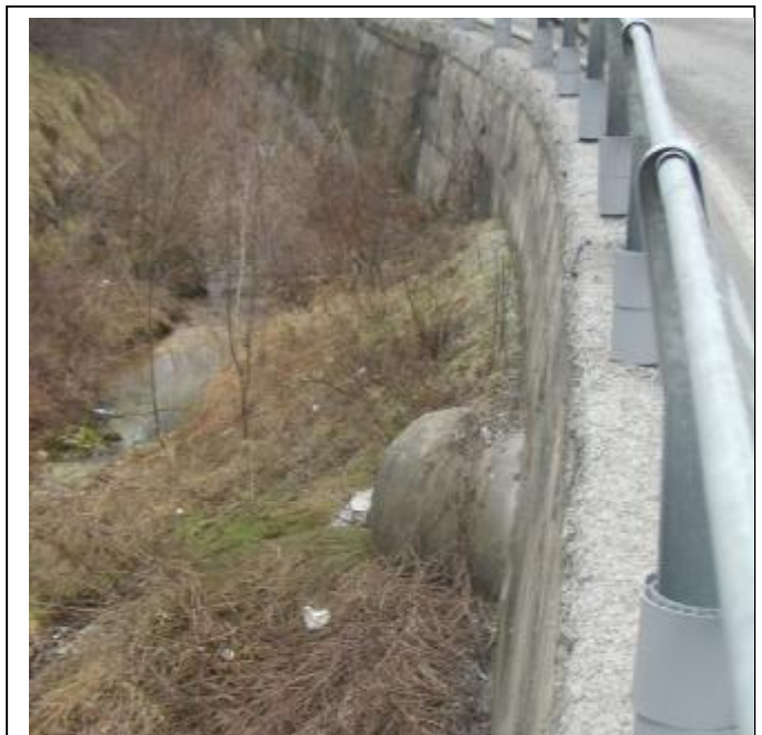
Foto 11 Sezione di valle dell'attraversamento
