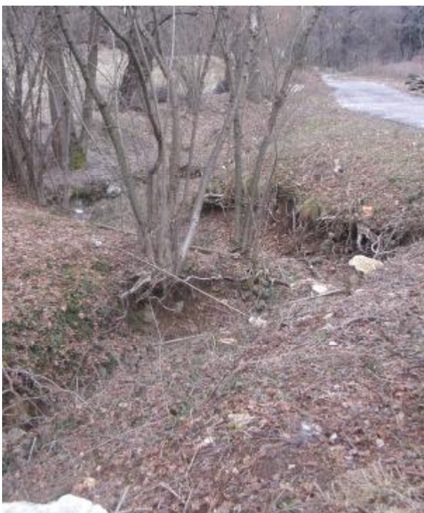
Foto 3 Particolare dell'alveo con sponde in erosione a quota 460 m s.l.m.
