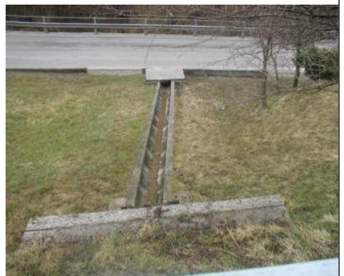
Foto 4 Canaletta in cls tra l'attraversamento C e l'attraversamento D
