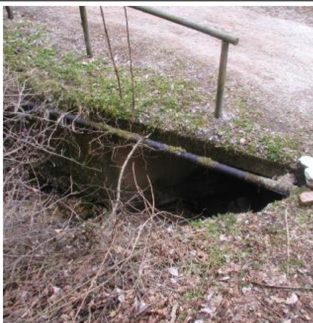
Foto 7 Sezione di monte dell'attraversamento
