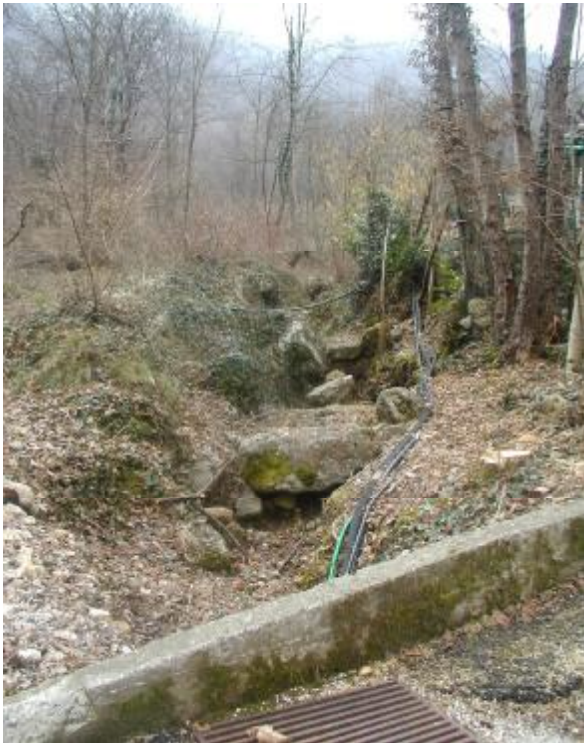
Foto 1 Particolare dell'alveo a monte dell'attraversamento
