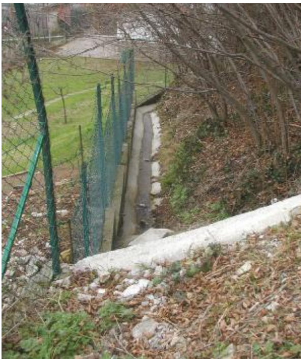
Foto 3 Tratto d'alveo regimato a valle dell'attraversamento A
