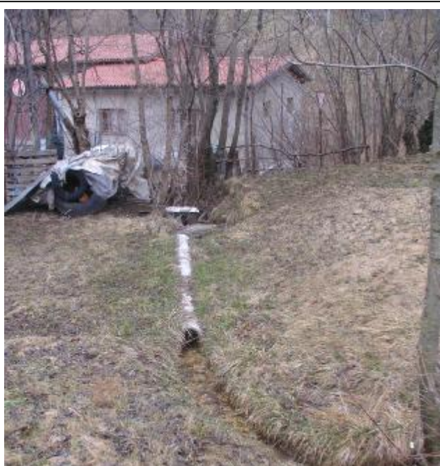
Foto 5 Vista dell'attraversamento da monte
