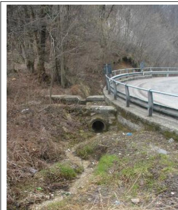
Foto 7 Vista dell'attraversamento da monte
