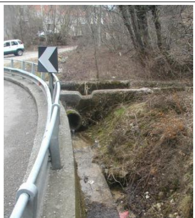
Foto 8 Sezione di valle dell'attraversamento
