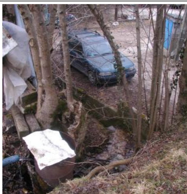
Foto 6 Inizio del tratto regimato a valle dell'attraversamento A
