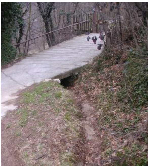
Foto 3 Particolare dell'alveo immediatamente a monte dell'attraversamento.
