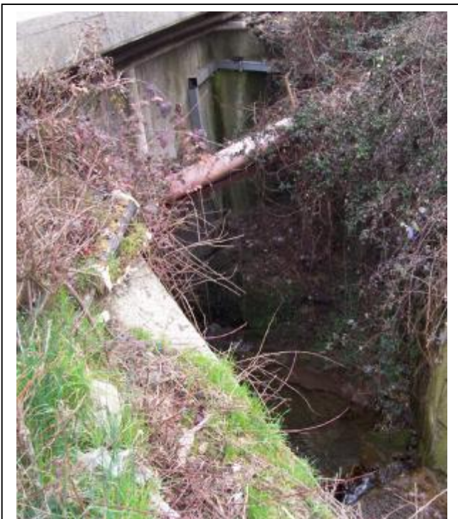
Foto 7 Vista dell'attraversamento da monte
