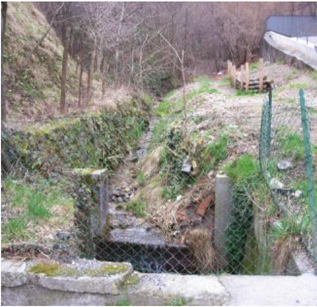
Foto 1 Particolare dell'alveo a monte dell'attraversamento A
