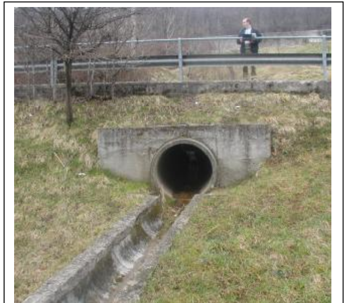
Foto 9 Sezione di valle dell'attraversamento
