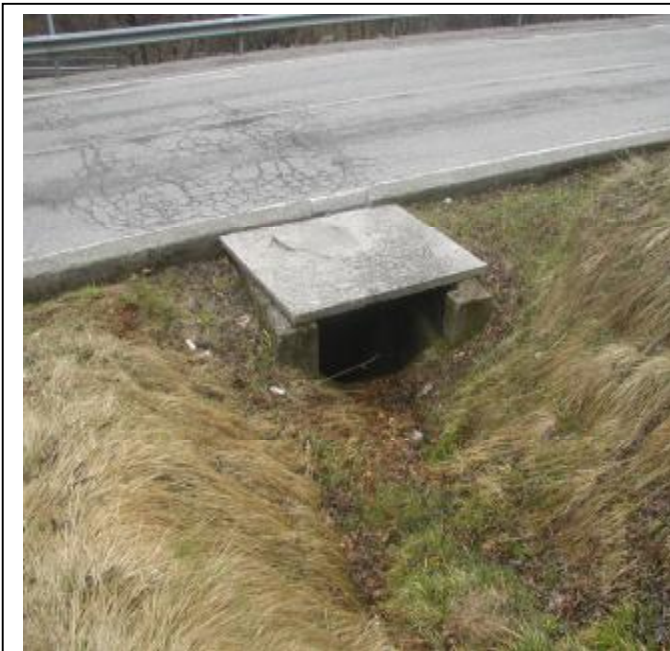
Foto 8 Sezione di monte dell'attraversamento
