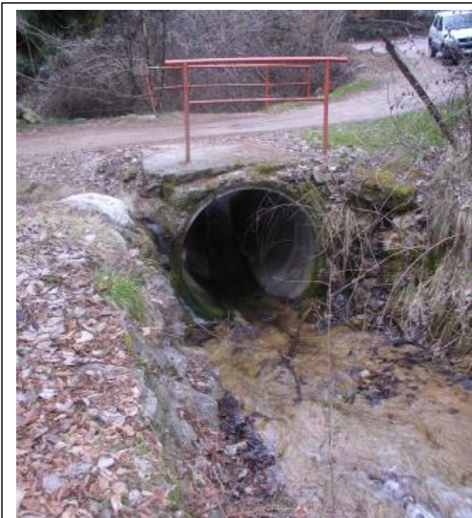
Foto 5 Sezione di monte dell'attraversamento
