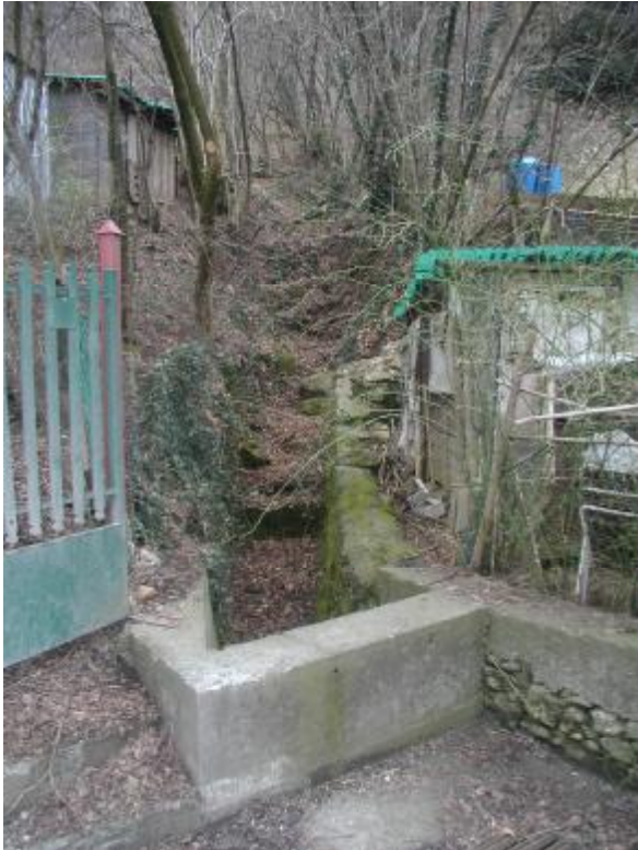
Foto 1 Particolare dell'alveo a monte dell'attraversamento
