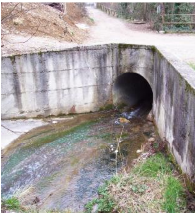
Foto 5 Sezione di monte dell'attraversamento
