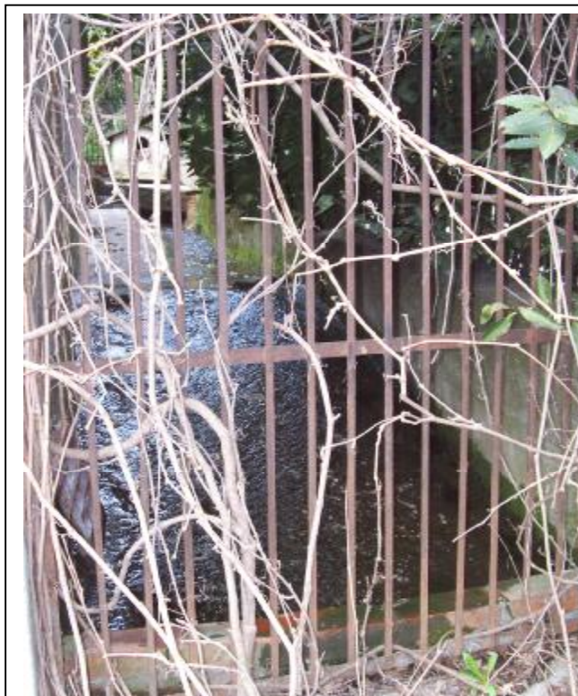
Foto 10 Tratto canalizzato compreso tra l'attraversamento C e l'attraversamento D
