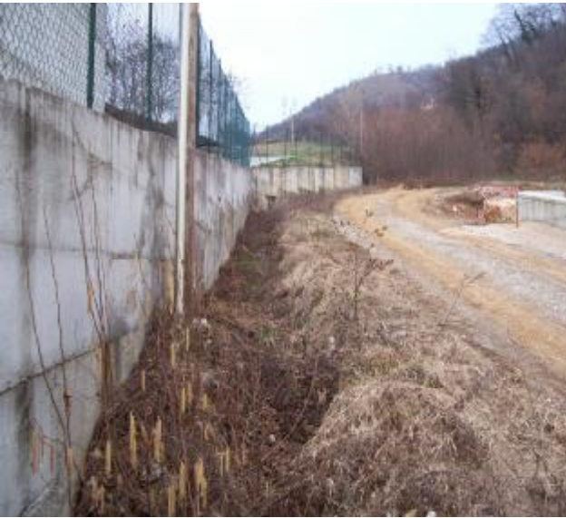
Foto 1 Detrito e resti vegetali in alveo a monte dell'attraversamento
