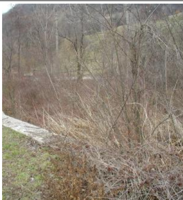
Foto 4 Alveo fittamente vegetato a valle dell'attraversamento B
