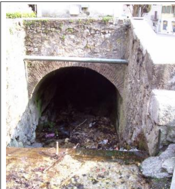
Foto 11 Sezione di monte dell'attraversamento, in primo piano una soglia.
