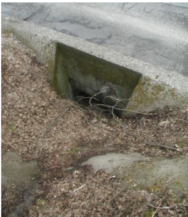
Foto 3 Sezione di monte dell'attraversamento
