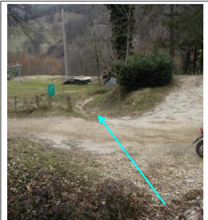
Foto 3 Guado in terra sulla strada comunale della "Casa Bruciata"
