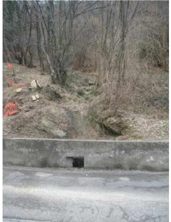
Foto 2 Vista dell'attraversamento dalla S.S. 237
