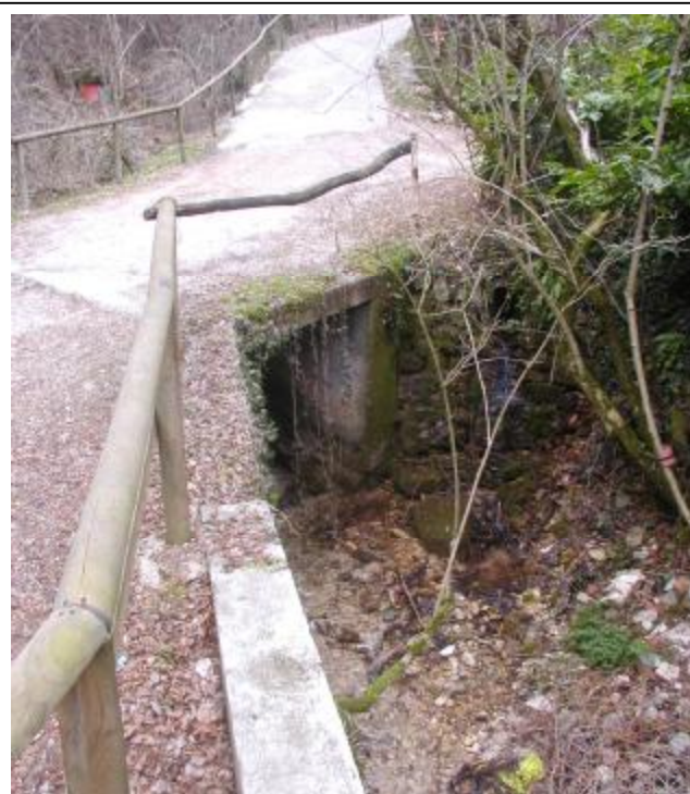
Foto 8 Sezione di valle dell'attraversamento
