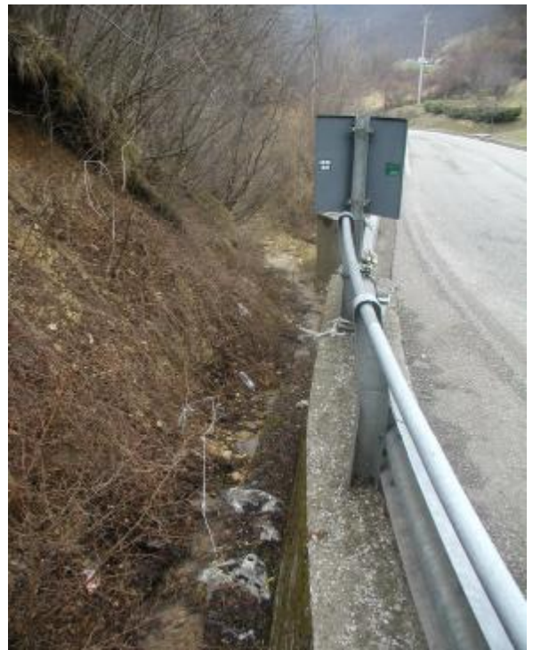
Foto 4 Particolare dell'alveo a valle dell'attraversamento B
