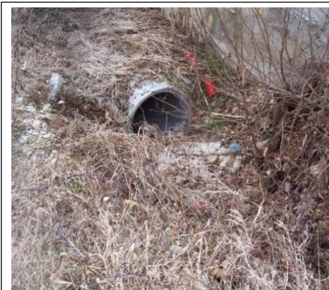
Foto 3 Sezione di monte dell'attraversamento
