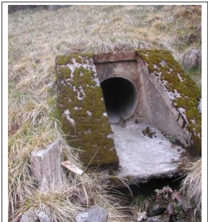
Foto 6 Sezione di valle dell'attraversamento
