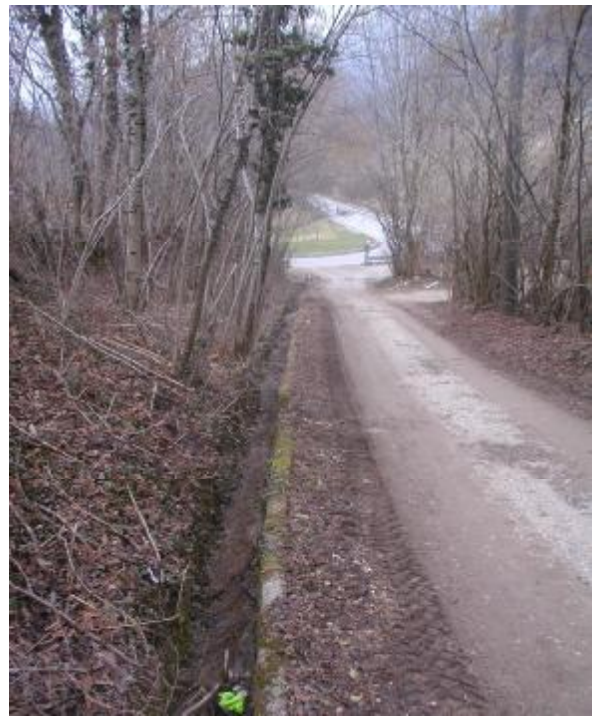
Foto 2 Particolare della canaletta in cls a valle dell'attraversamento A
