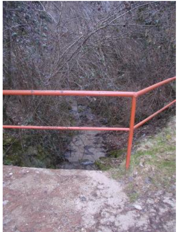
Foto 2 Alvo con sponde vegetate a valle dell'attraversamento A
