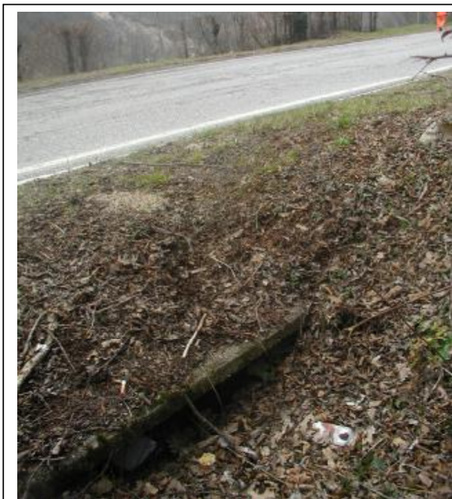
Foto 5 Sezione di monte dell'attraversamento
