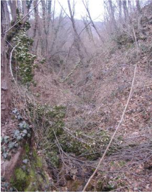
Foto 1 Particolare dell'alveo a monte dell'attraversamento
