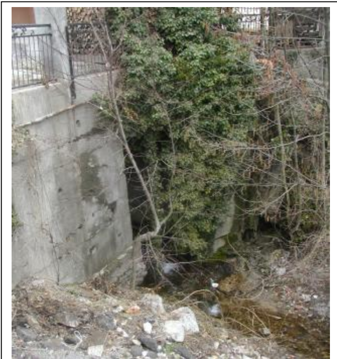
Foto 9 Sezione di valle dell'attraversamento, termine del tratto tombinato
