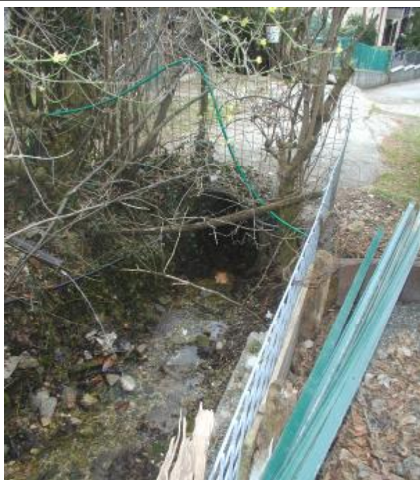
Foto 4 Sezione di monte dell'attraversamento
