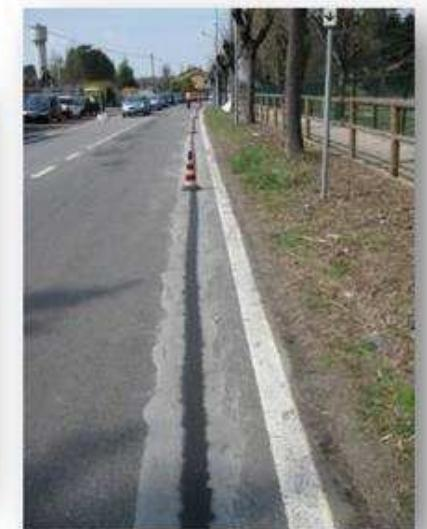
**Figura 5 - Caratteristiche estetiche finali dello scavo in minitrincea**
