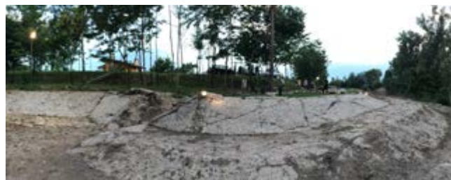
Il sito di via Casoni come si presenta oggi dopo i lavori di recupero
