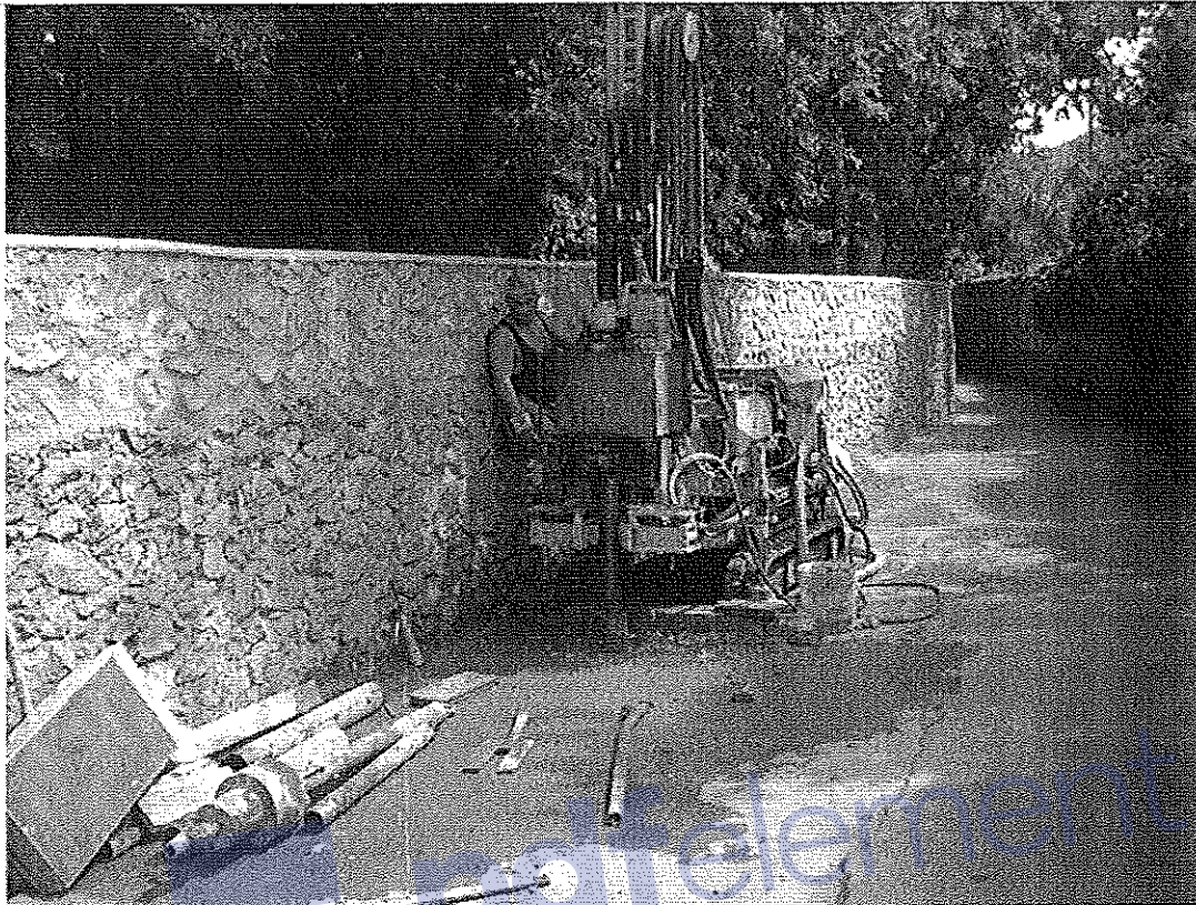
FOTO N.12: POSTAZIONE SONDAGGIO S3
