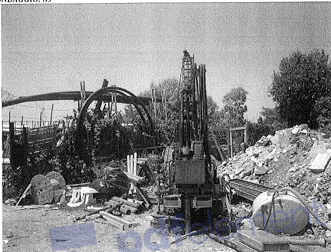
FOTO N.24: POSTAZIONE SONDAGGIO S5
