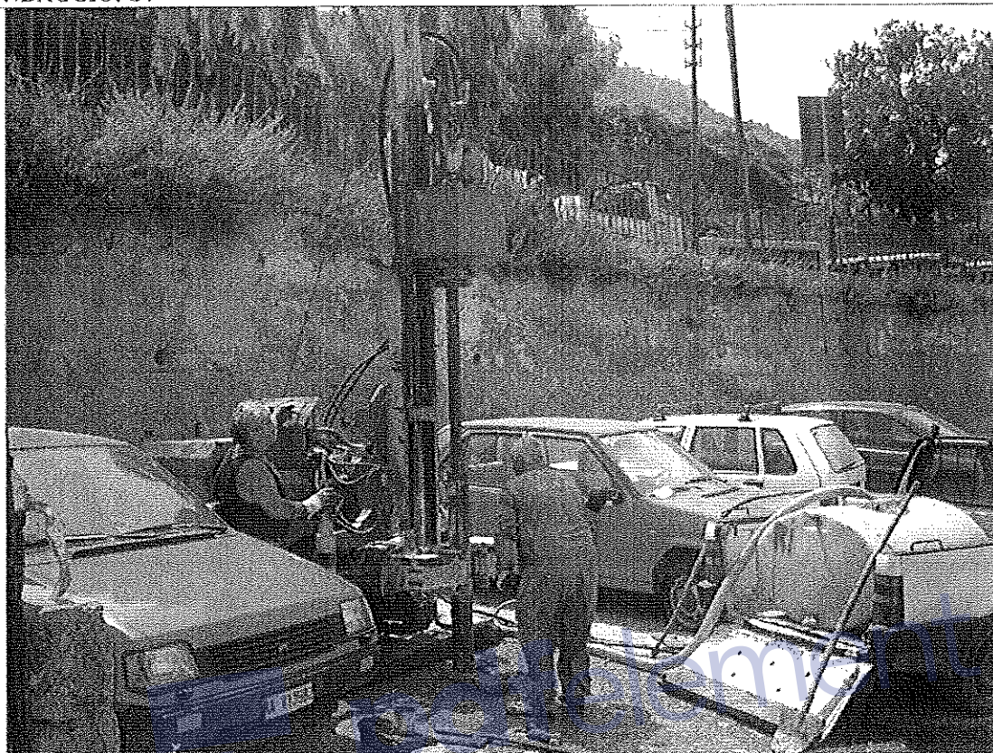
FOTO N.18: POSTAZIONE SONDAGGIO S4
